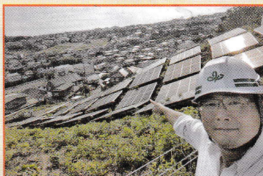
急傾斜地のソーラーパネルの土砂災害対策は急務です。
