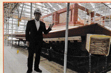
多賀城創建1300年に向け、多賀城南門の復元工事を進めています。
